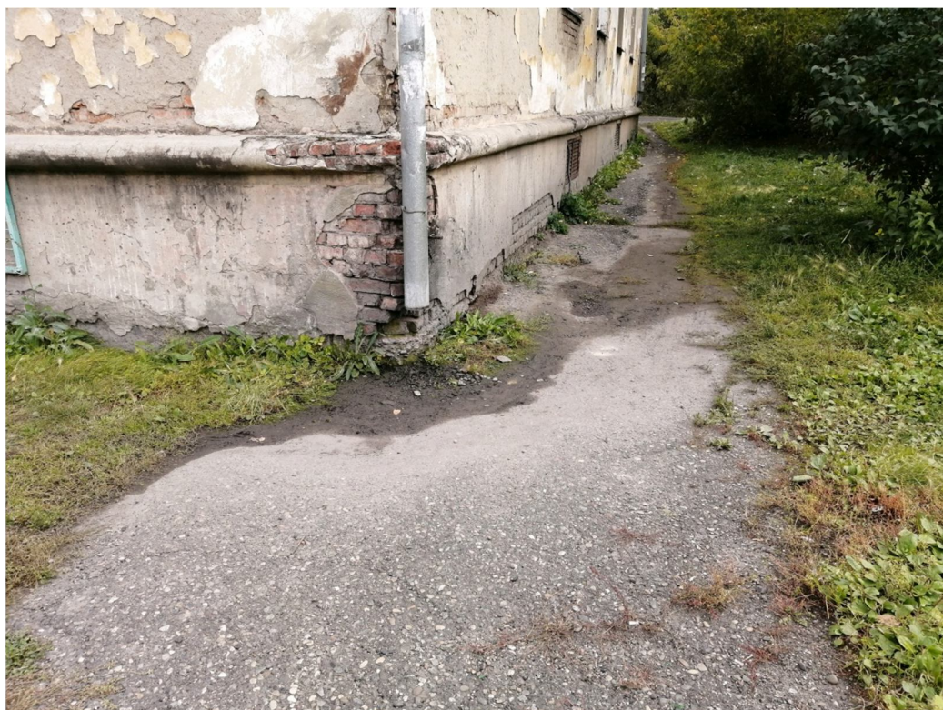
Рис.№3. Состояние отмосток.
